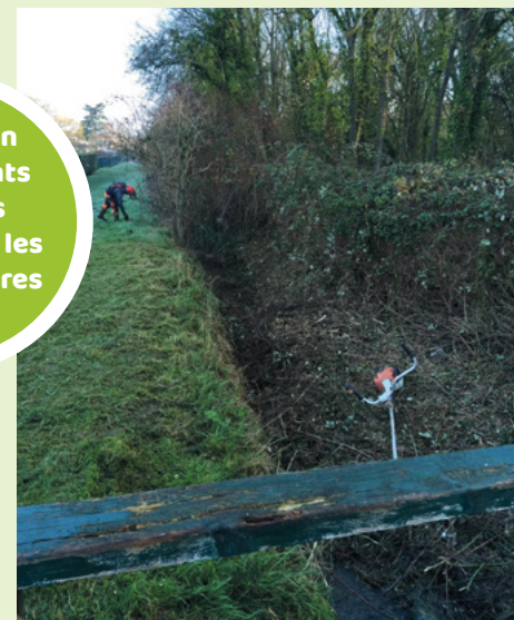
Réouverture de cours d'eau
