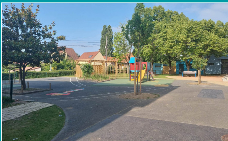
Le projet de désimperméabilisation de la cour d'école Jean MACE à Palaiseau répond à plusieurs enjeux : adaptation au changement climatique, bien-être de l'enfant, confort thermique... Plusieurs espaces, avec des usages différents, sont maintenant matérialisés dans la cour.
