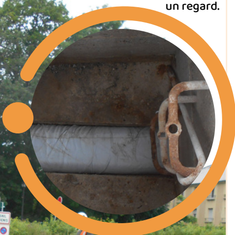
Gaine en place dans un regard.
