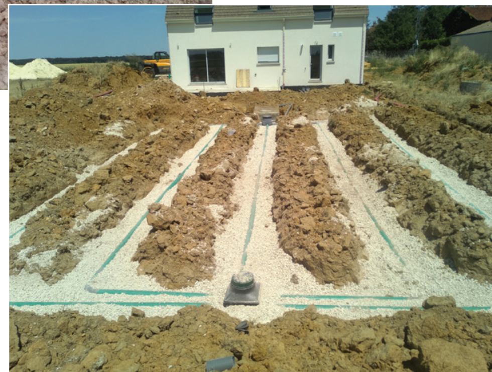
Mise en conformité d'assainissement non collectif
