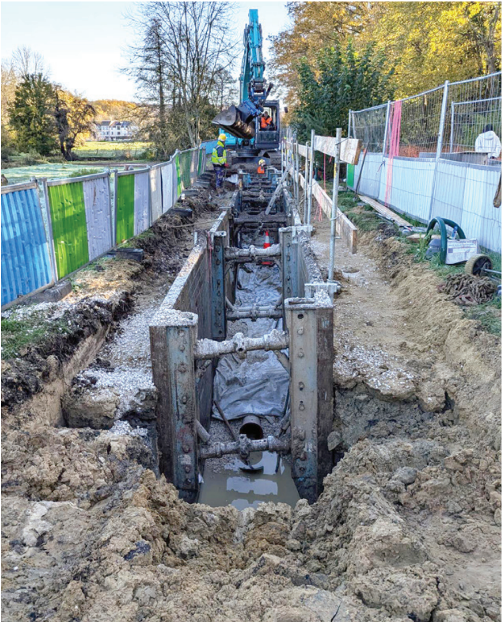
Pose de la canalisation au niveau de la piste cyclable existante
