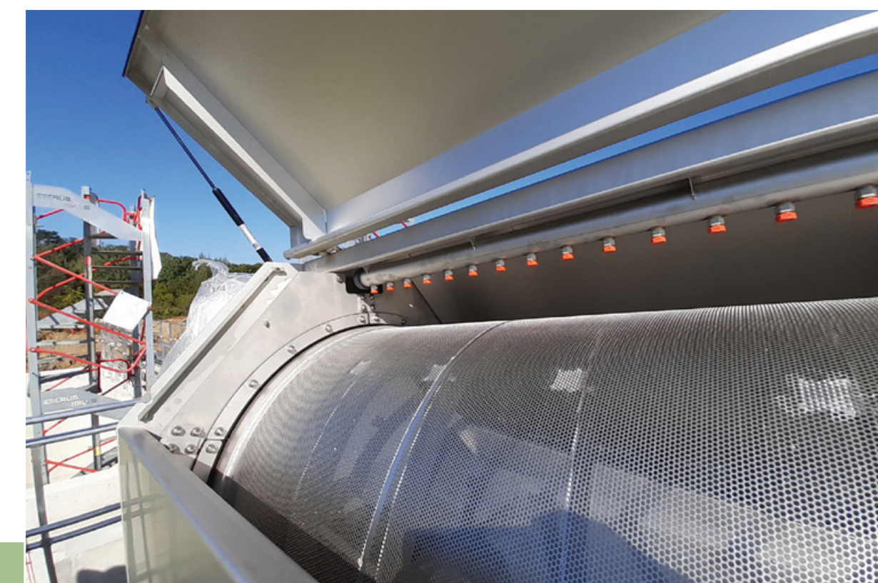
Mise en place du tamis rotatif
