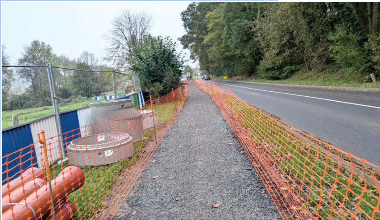
Création d'une piste provisoire pour les piétons et les cyclistes
