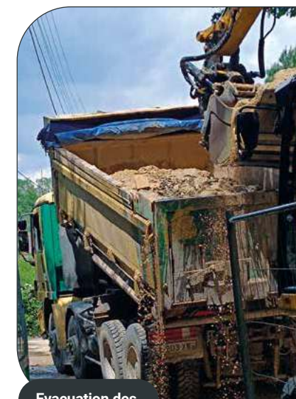
Evacuation des terres excavées gorgées d'eau
