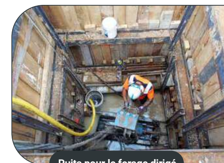
Puits pour le forage dirigé
