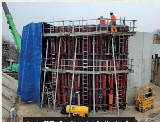
Janvier 2025 – Ferrailage et réalisation du voile courbe extérieur du bassin anaérobie/anoxie
