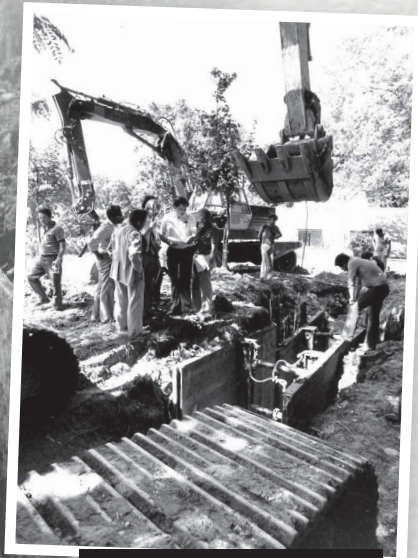
1974, réalisation du doublement du collecteur et création du bassin de la Mérantaise
