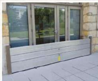
L'installation de batardeaux devant les portes peut faire partie des dispositifs préconisés
