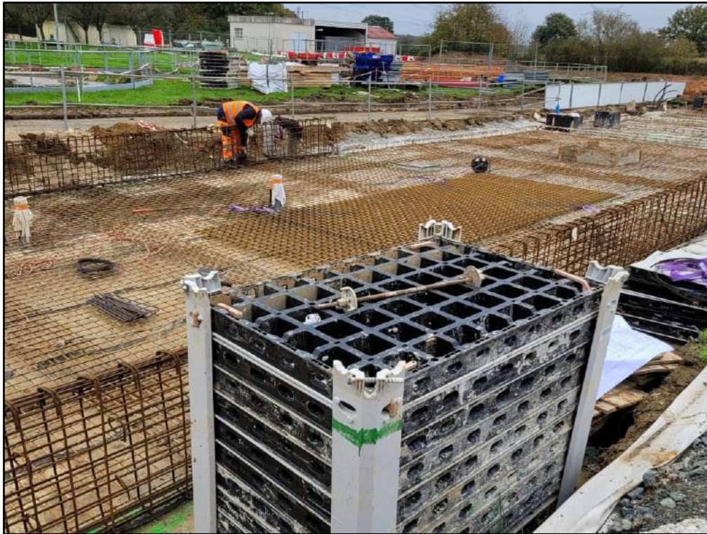
Figure 11 : STEU de La Verrière / Le Mesnil-Saint-Denis Ferrailage des radiers et des longrines des locaux d'exploitation (source : SIAHVY)
