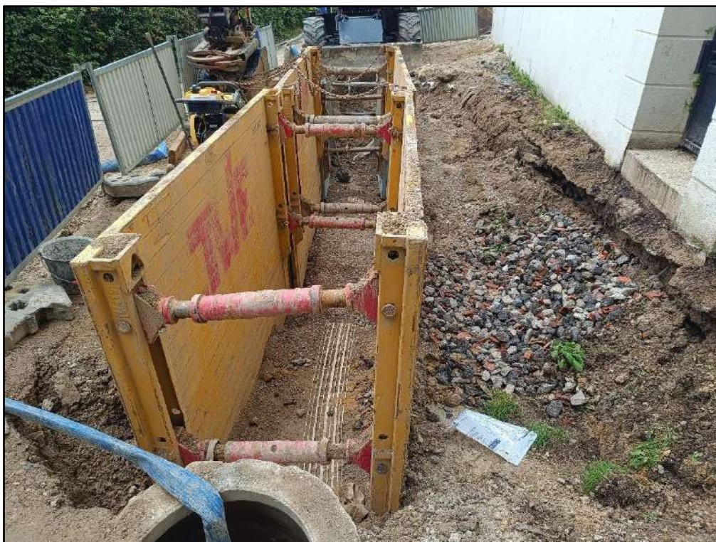
Figure 4 : Rue des Sources à Boullay-les-Troux Remblaiement de la tranchée - Mise en place du grillage avertisseur (source : SIAHVY)
