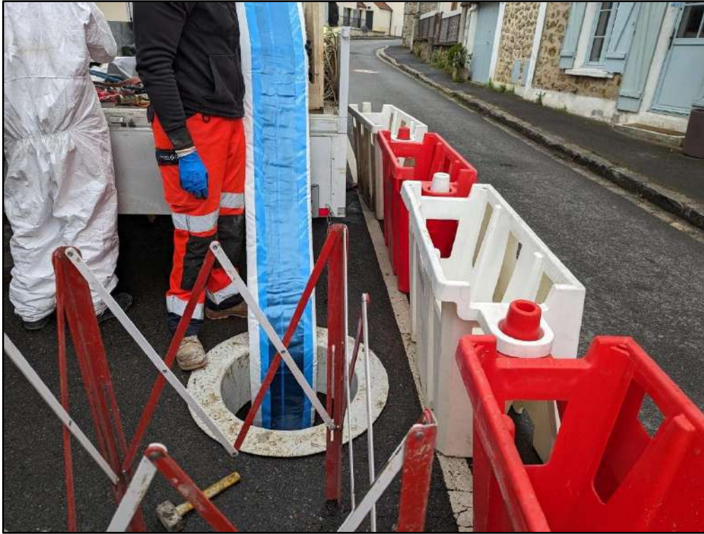
Figure 8 : Carrefour de la Bastille aux Molières Introduction de la gaine (source : SIAHVY)
