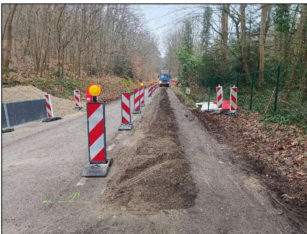
Figure 5 : Route des Sablières à Choisel Mise en place de la signalisation provisoire - Rabotage de la chaussée (source : SIAHVY)
