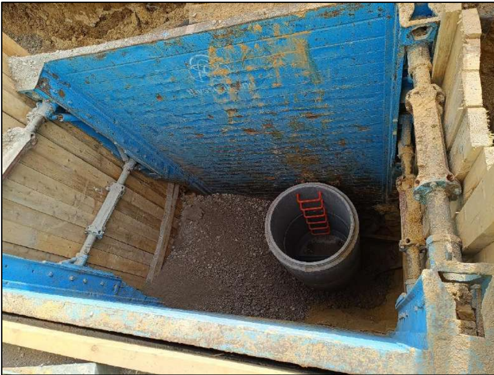
Figure 6 : Rue de la Gruerie à Gometz-la-Ville Pose des éléments de fond d'un regard (source : SIAHVY)
