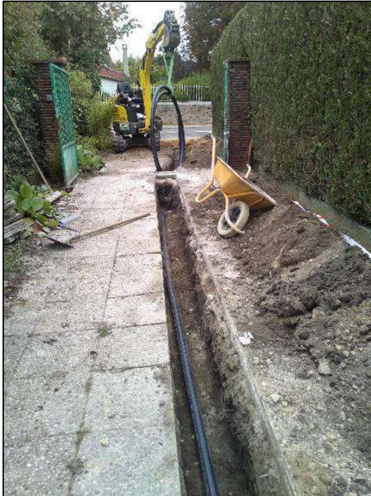
Figure 10 : Propriété privée - Hameau de Garnes (tranche 2) à Senlisse Pose d'un branchement en refoulement (source : SIAHVY)
