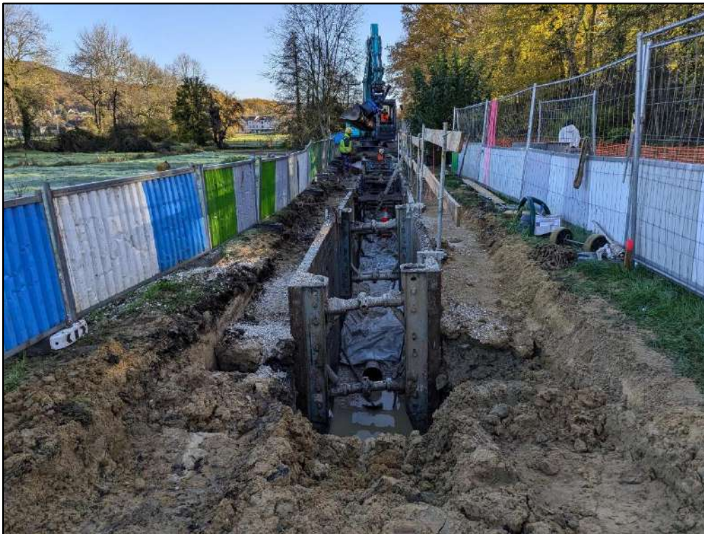
Figure 9 : Chemin de Coubertin à Saint-Rémy-lès-Chevreuse Enrobage de la canalisation (source : SIAHVY)
