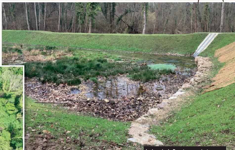
Le bassin du Baratage après travaux
